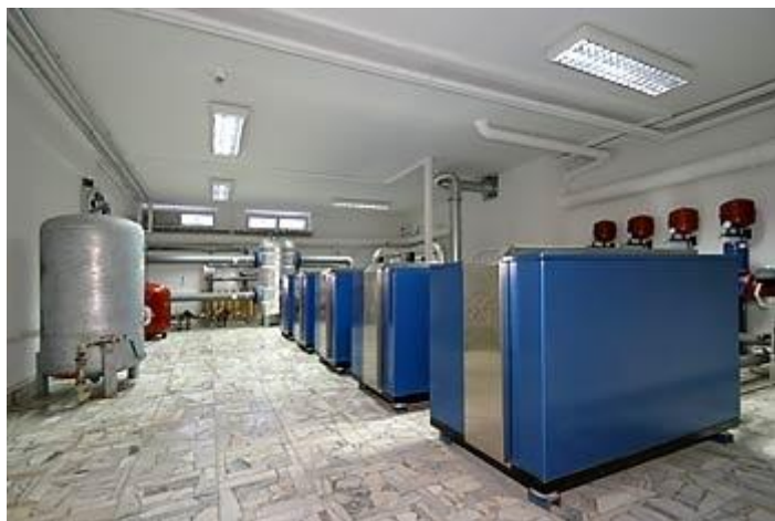
Instalacja grzewcza o mocy 300 kW w Centrum Dialogu i Modlitwy w Oświęcimiu (źródło www.vatra.pl )
